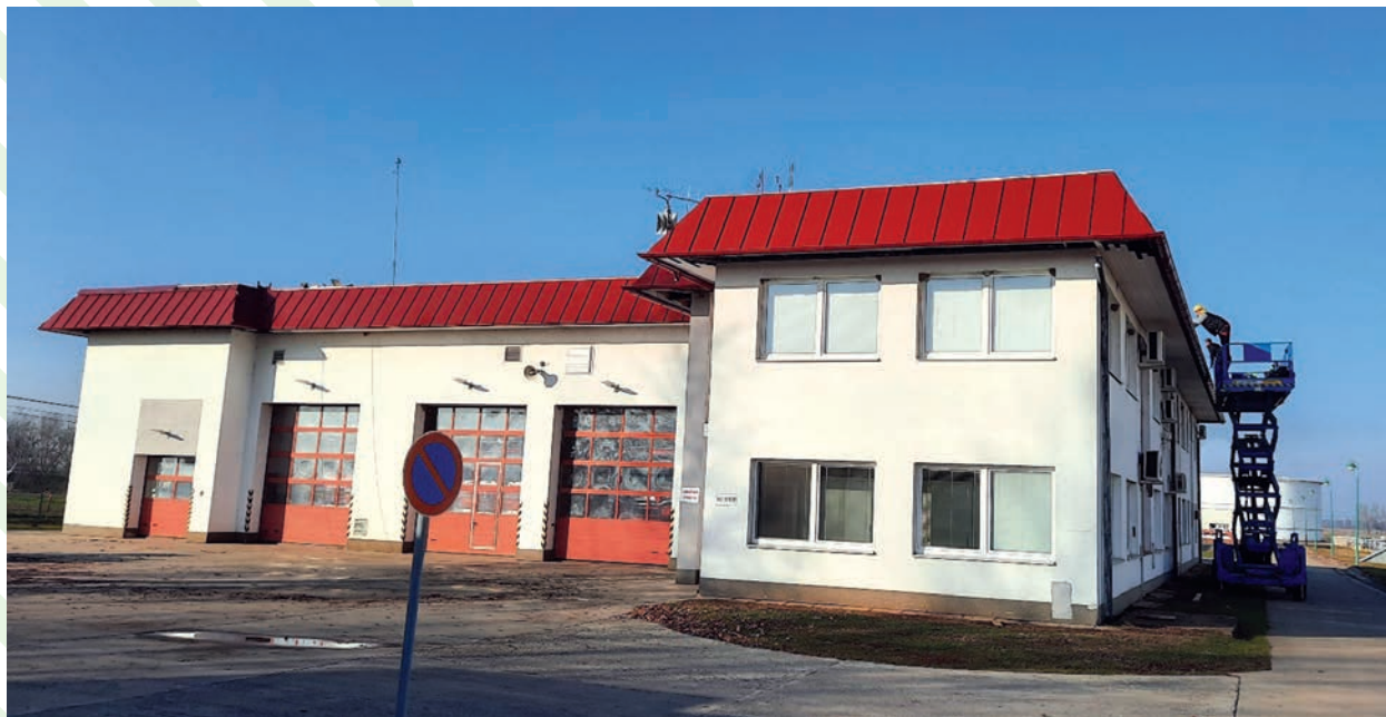
Obr.: Rekonštrukcia strechy objektu ZHÚ v PS-1 Budkovce
