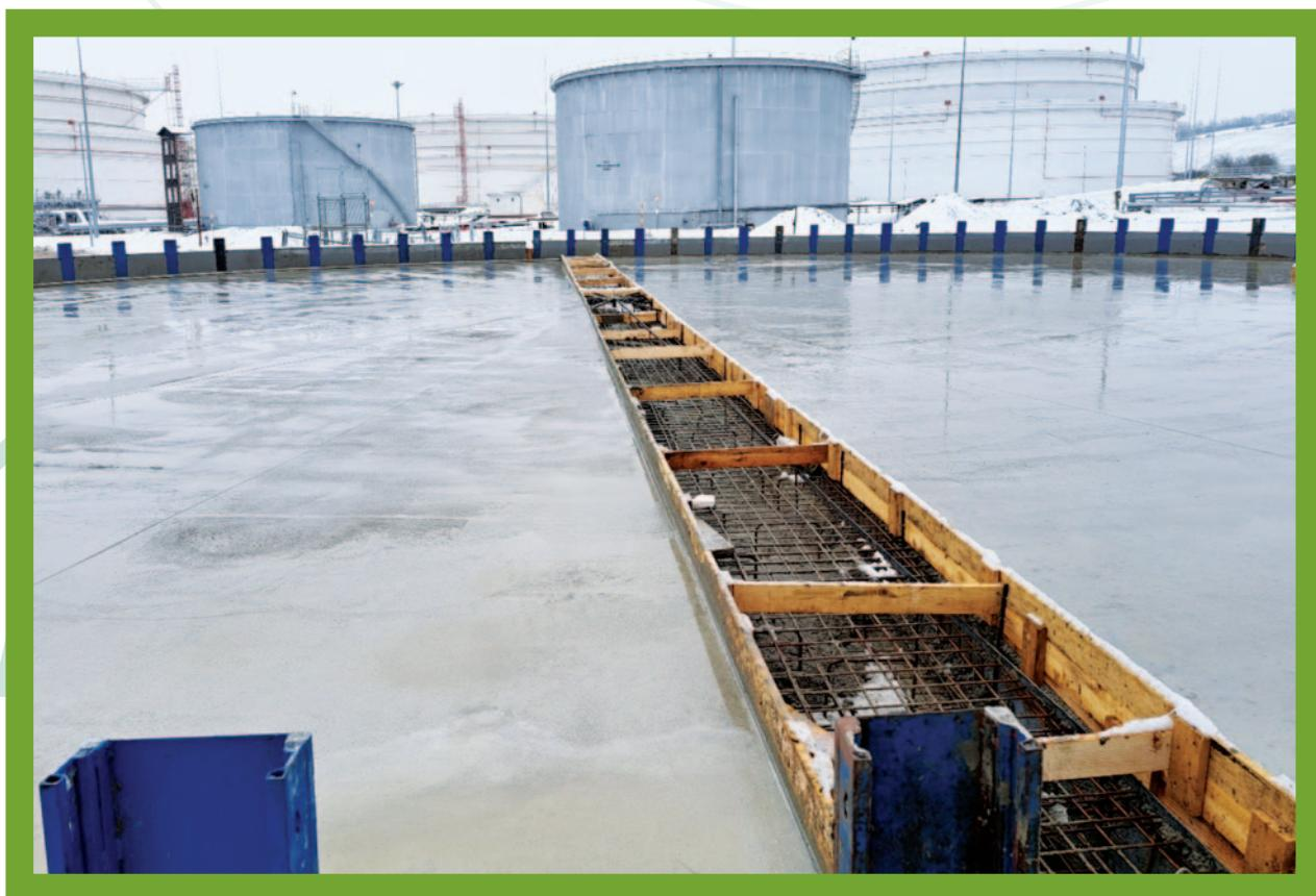
Obr.: Práce na základe novej nádrže požiarnej vody, v pozadí pôvodné nádrže požiarnej vody a odpadových vôd
